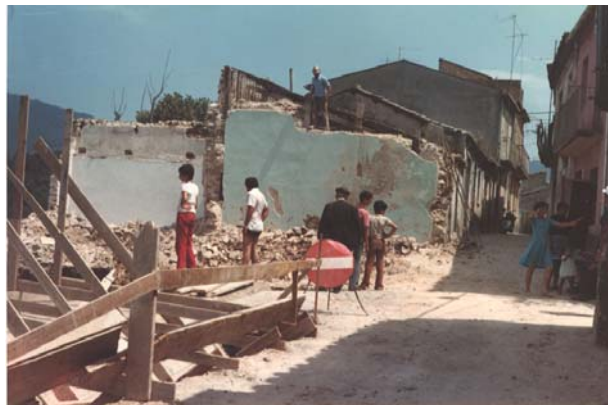
Sbancamento dell'area dove sorgeva la Chiesa (luglio 1979)
